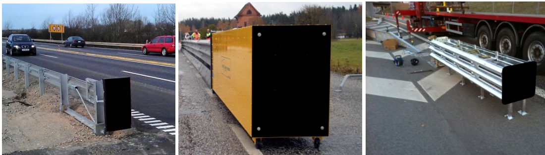
Figur 7.50 Eksempler på energiabsorberende trafikværsender.
