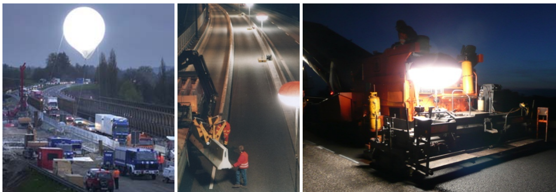
Figur 2.3 Eksempler på ballonbelysning af arbejdsområdet
