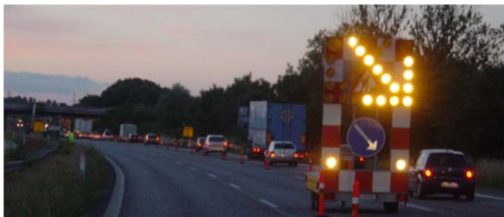
Figur 7.32 Eksempel afspærringsvogn med tændt lyspil og bundblink.
