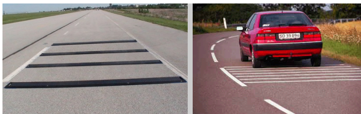
Figur 7.58 Eksempler på mobile og stationære rumlestriber.
