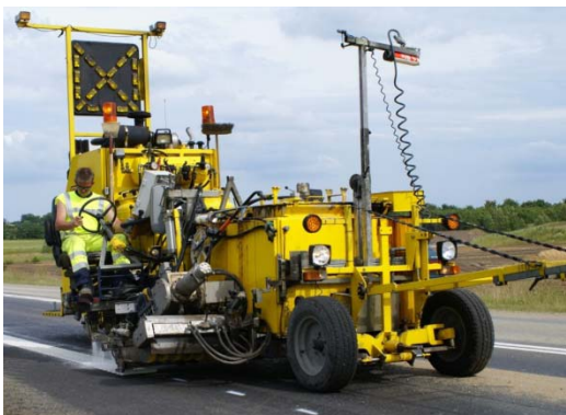
Figur 5.2 Eksempel på afstribning af kantlinje.
