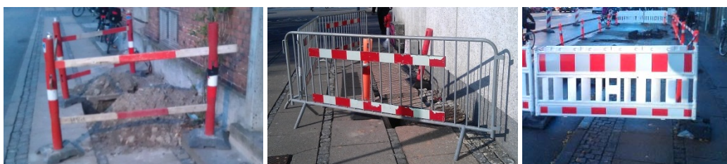
Figur 4.10 Eksempler på tværafspærring på fortov.
