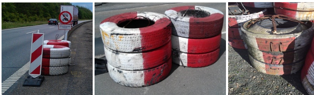
Figur 7.49 Eksempler på dæksøjler som er forsvarligt sammenkoblede.
