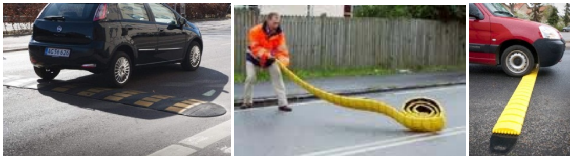
Figur 7.57 Eksempler på midlertidige bump.
