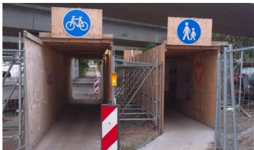
Figur 4.28 Eksempel på interimssti ved vejarbejde.
