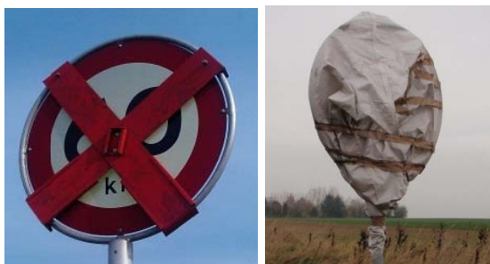
Figur 4.3 Eksempler på annullering af færdselstavler.
