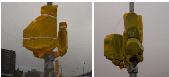
Figur 4.25 Eksempler på tildækning af lyssignaler med gule sække.
