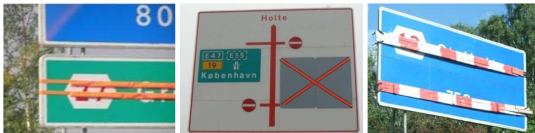
Figur 4.4 Eksempler på annullering af vejvisningstavler.
