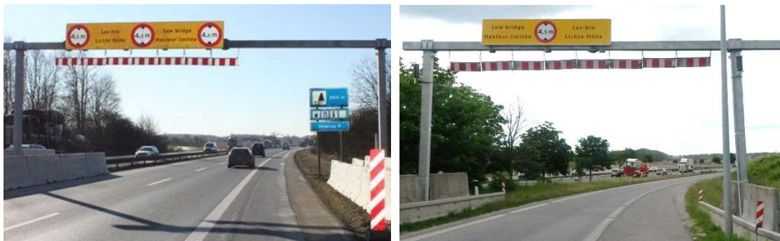
Figur 7.52 Eksempler på højdevarslingsportaler med metalplader (rasleplader).
