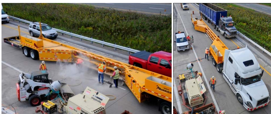
Figur 7.55 Eksempel på beskyttelsesmodul (her mobile-work-zone-barrier).
