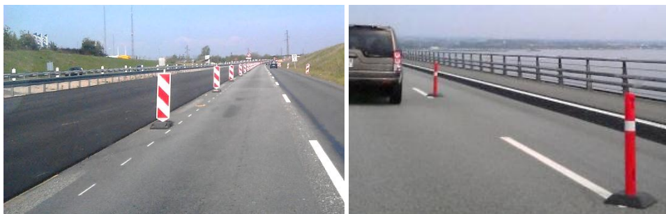
Figur 4.11 Eksempler på længdeafspærring mellem arbejdsområde og kørebane.
