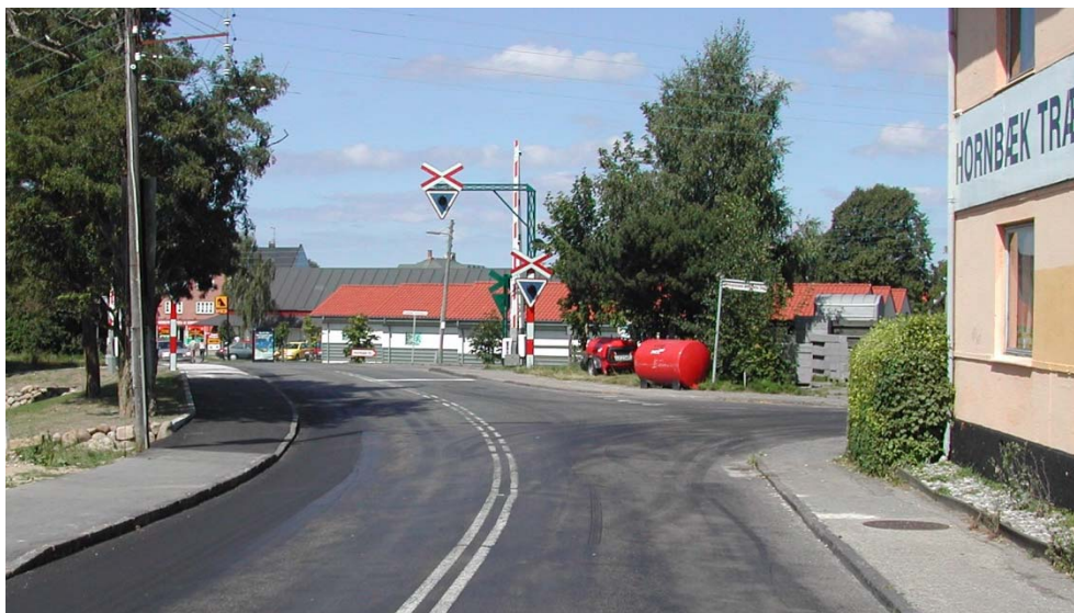
Figur 5.7 Eksempel på jernbaneoverkørsel med højtsiddende vejsignal.
