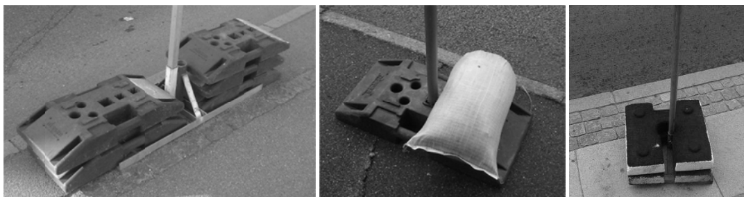
Figur 7.35. Eksempler på stabilisering af tavlestandere.
